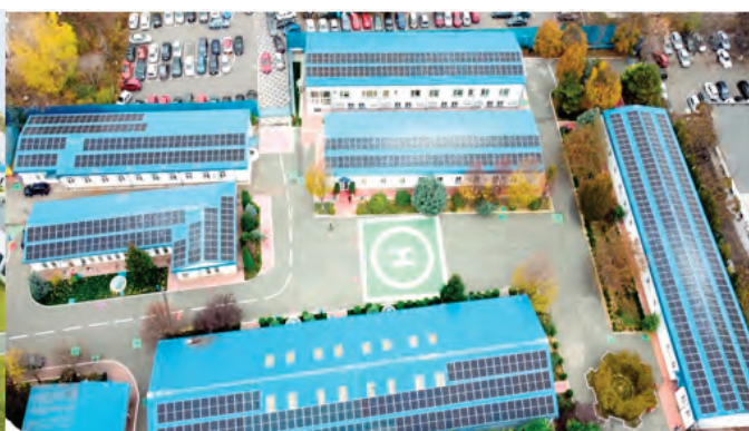
CEF Sediul Călărași / Calarasi PV Power Plant
