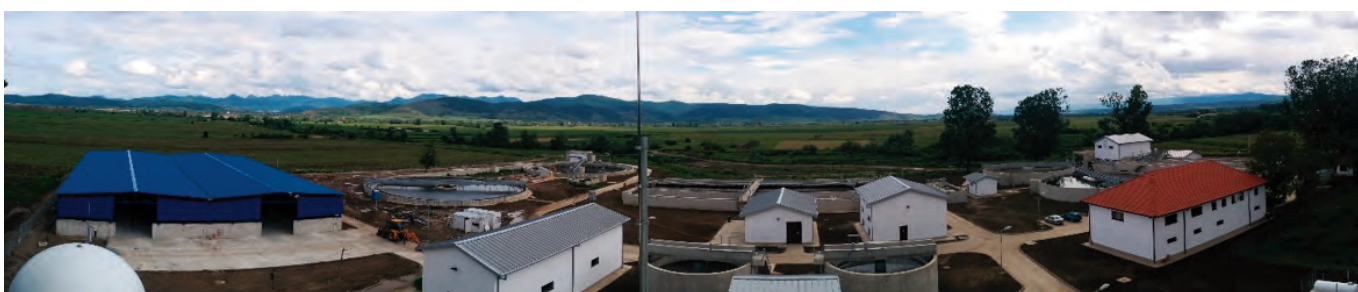
Fig. 5. Stația de Epurare a Apelor Uzate Hunedoara / Hunedoara Wastewater Treatment Plant
