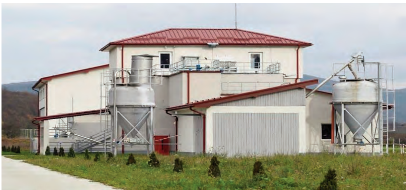
Fig. 3. Stație Tratare Crișcior / Criscior Treatment Plant
