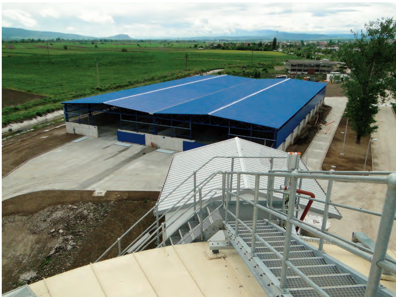
Fig. 7. Depozit nămol Deva / Deva sludge deposit
