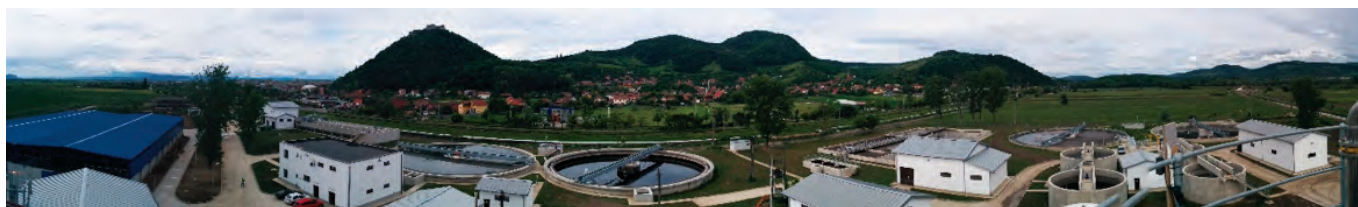
Fig. 4. Stația de Epurare a Apelor Uzate Deva / Deva Wastewater Treatment Plant
