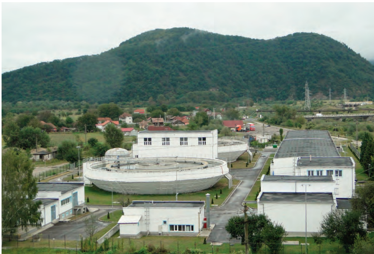
Fig. 2. Stația de Tratare a Apei Sântămăria-Orlea / Santamaria-Orlea Water Treatment Plant
