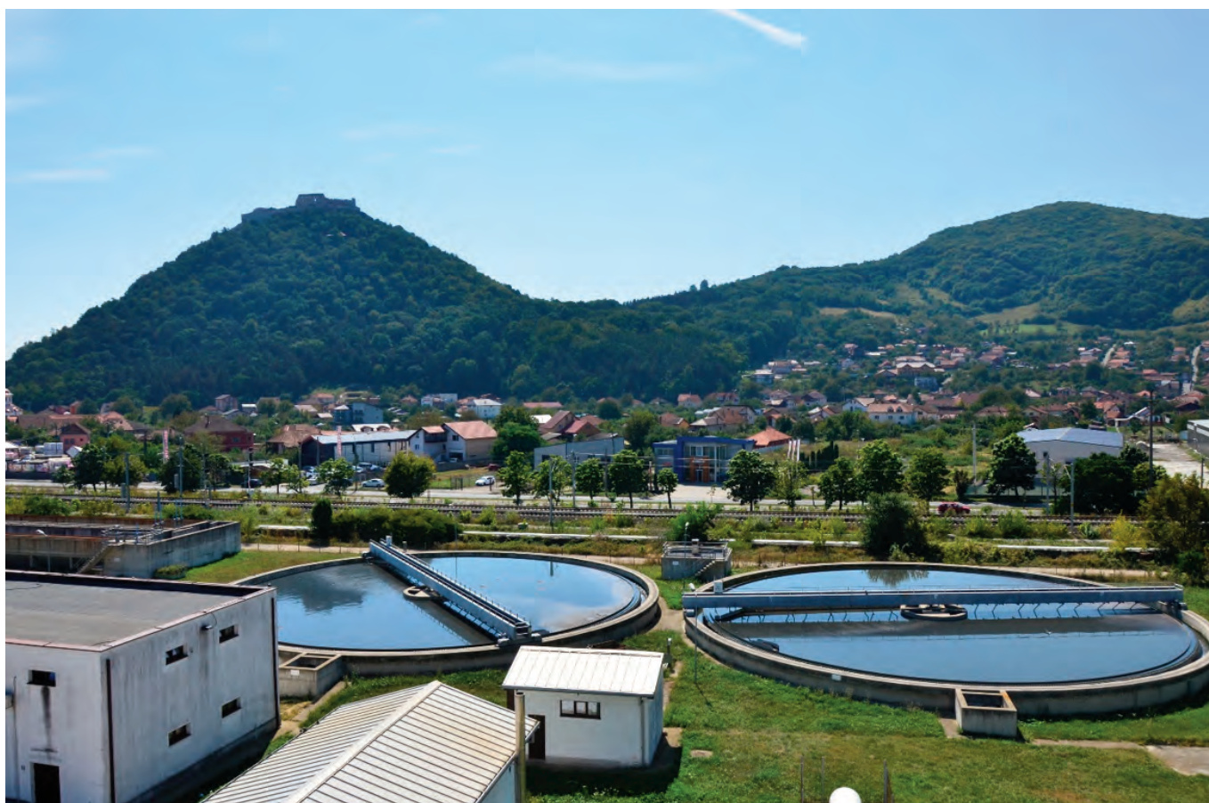
Fig. 6. Stația de Epurare a Apelor Uzate Deva / Deva Wastewater Treatment Plant
