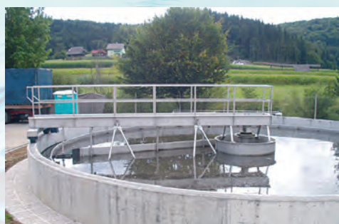
PODURI RACLOARE CU TRACȚIUNE PERIFERICĂ PTA - PTP
