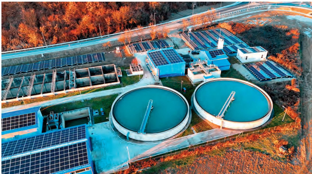
Fig. 8. Stație Tratare apă Beclean / Beclean Water Treatment Plant
