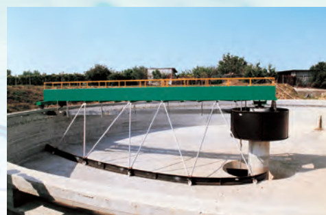
PODURI RACLOARE CU TRACȚIUNE PERIFERICĂ PTA - PTP
