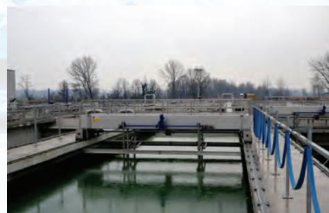
PODURI RACLOARE DECANTOARE SECUNDARE PVS - PVV
