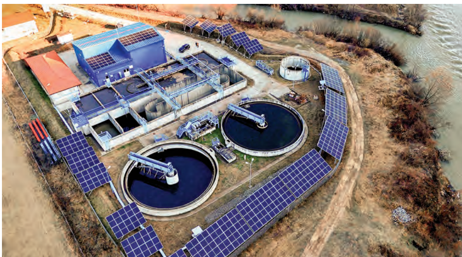
Fig. 11. Stație epurare apă uzată Salva / Salva Wastewater Treatment Plant
