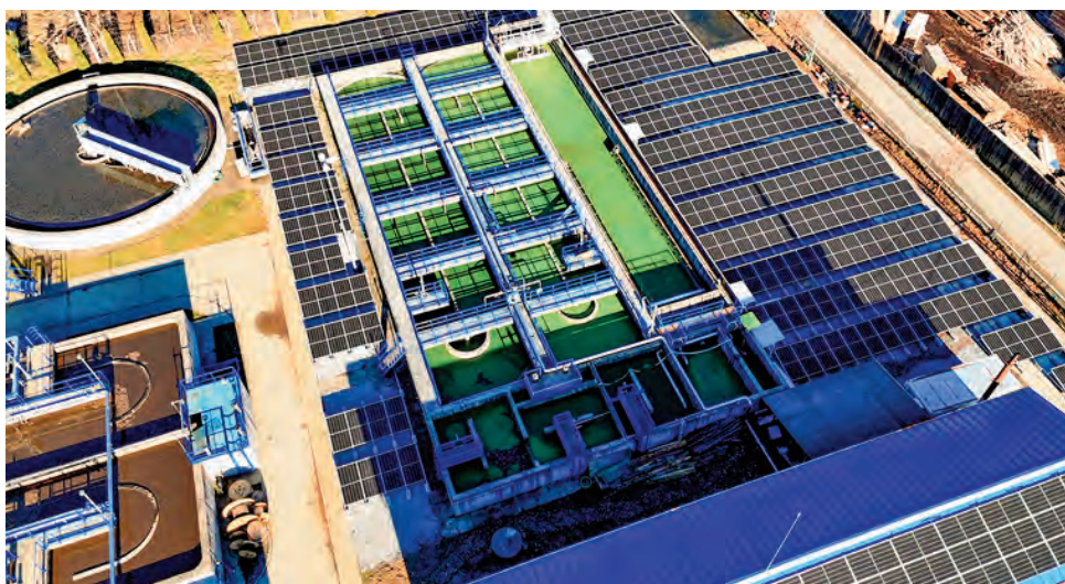
Fig. 12. Stație epurare apă uzată Sângeorz-Băi / Sangeorz-Bai Wastewater Treatment Plant
