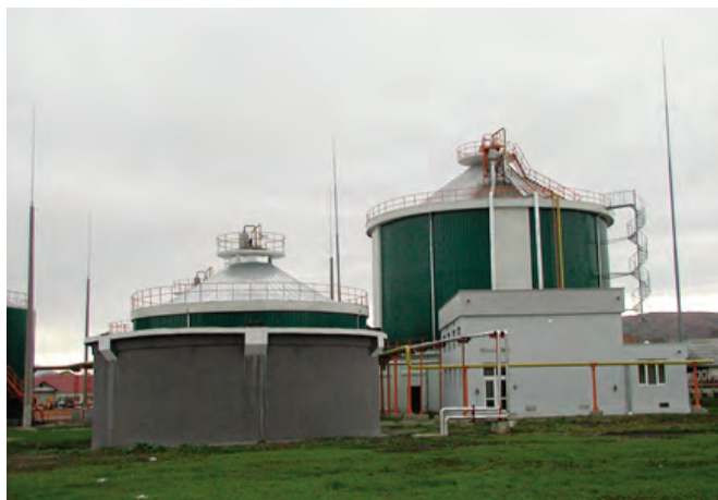
Fig. 10. Metantancuri - Stație epurare uzată Bistrița / Meta-tanks - Bistrita Wastewater Treatment Plant
