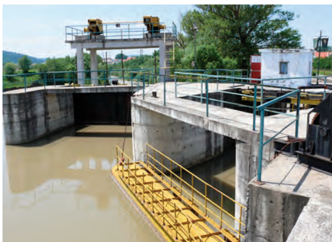
Fig. 4. Priza de apă - Stație Tratare Bistrița / Water intake - Bistrita Treatment Station
