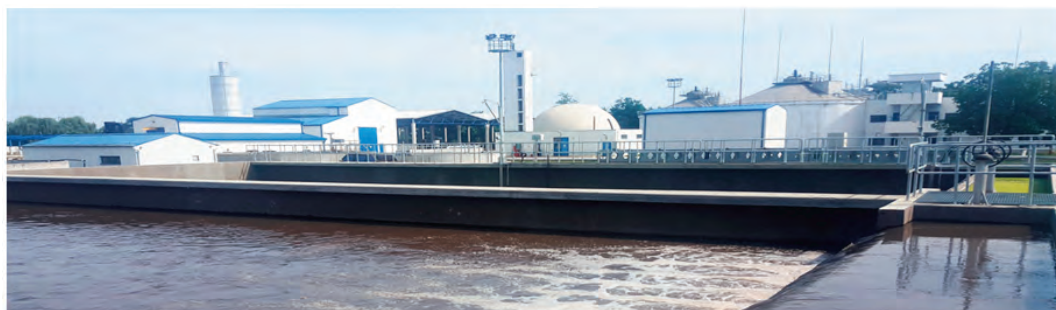
Fig. 3.4. Stația de epurare Satu Mare
